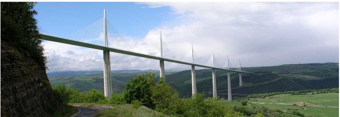
Illustration 391 – Le Rouergue, entre Préhistoire et modernité : viaduc de Millau enjambant la vallée du Tarn, Creissels, Aveyron.
