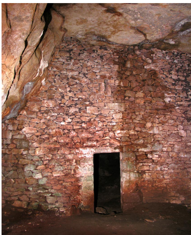
Illustration 146 – Mur intérieur de la cave à fromage d'Issis, Millau, Aveyron. À l'exception de l'encadrement de la porte (en clair), le mur a été jointoyé avec de l'argile prélevée sur place.
