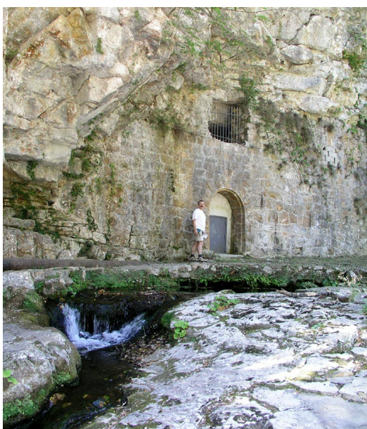
Illustration 61 – Mur de protection des Sourcets, Vence, Alpes-Maritimes.
