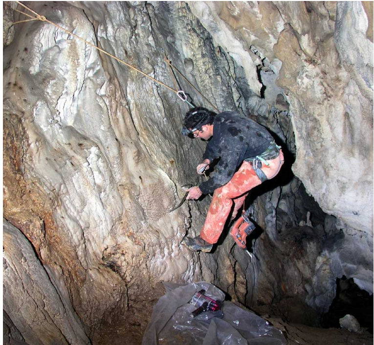
Illustration 160 – Pose de fers à béton (via ferrata) dans la grotte du Radar, Saint-Benoît, Alpes-de-Haute-Provence. Cet équipement était nécessaire pour ne pas avoir à emprunter un escalier préhistorique taillé dans l'argile.
