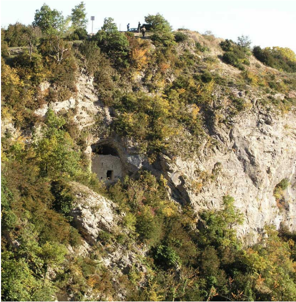
Illustration 50 – Le pertuis de Méailles, Alpes-de-Haute-Provence, est un ouvrage défensif sensé protéger un terroir autrefois plutôt riche.
