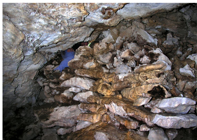
Illustration 64 – Le mur de soutènement de la grotte n° 2 de l'Euzière, Gorniès, Hérault, a permis de boucher une grotte en consommant le moins possible de remblais.
