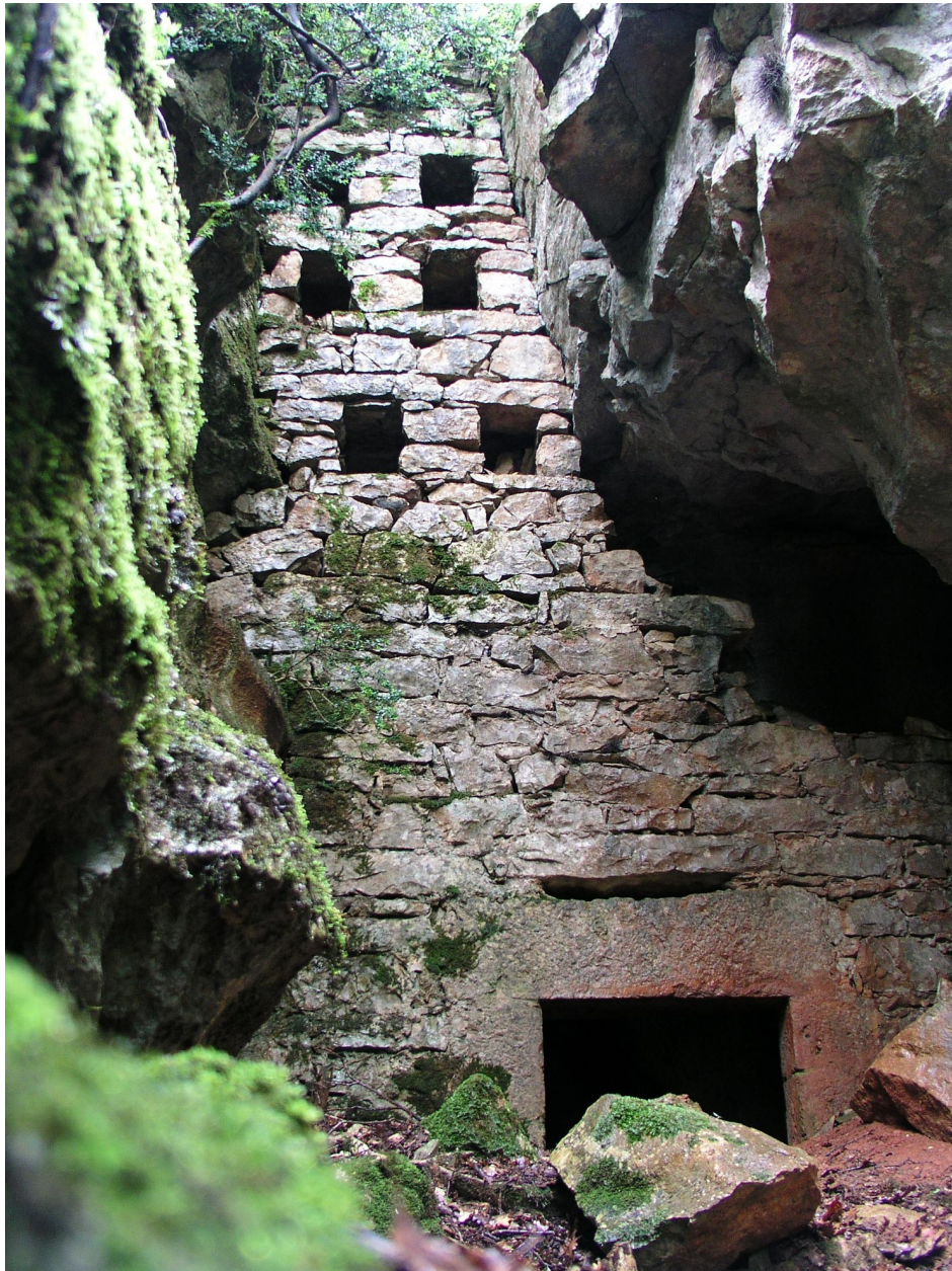
Illustration 45 – Mur d'entrée de la cave à fromages d'Issis, Millau, Aveyron.
