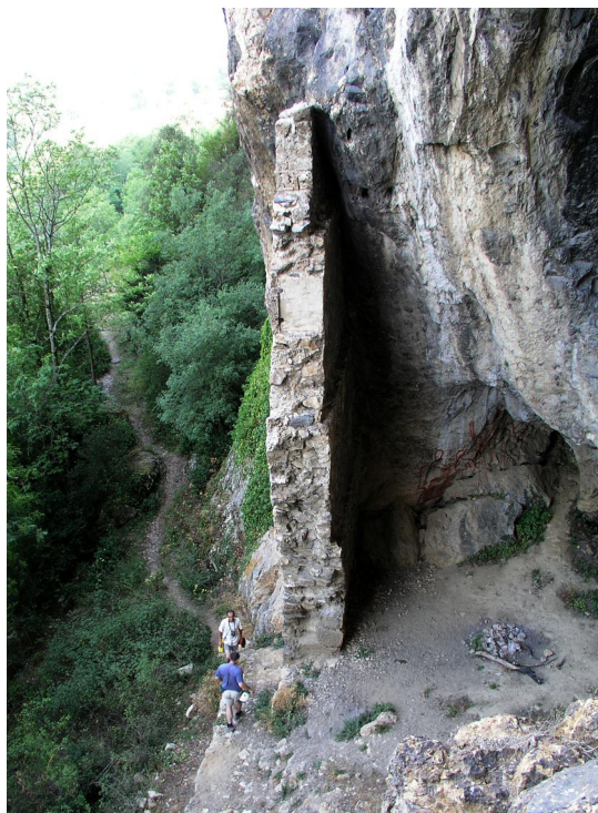
Illustration 74 – Mur de la spoulga de Bouan, Ariège, dont l'épaisseur variable matérialise les différents étages de la fortification.
